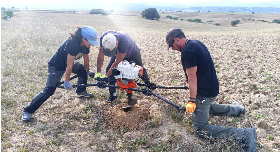
Figura 9. Operarios de Brinzal y voluntarios realizando las labores para colocación de los postes en el límite de la vía pecuaria.
