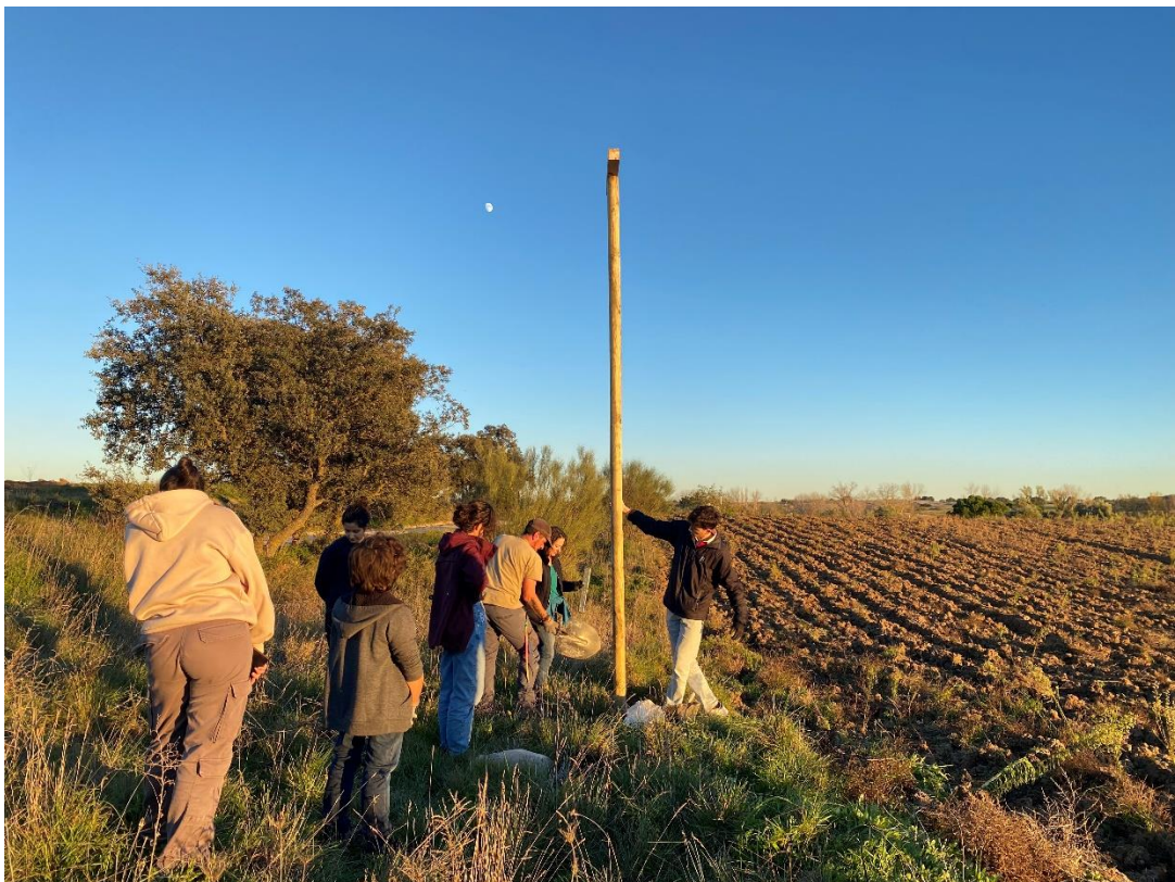
Figura 10. Operarios de Brinzal y voluntarios colocando los postes en el límite de la vía pecuaria.
