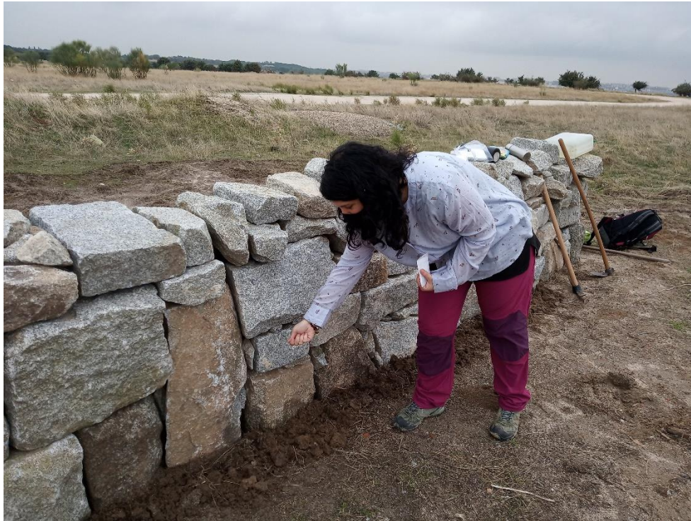
Figura 22. Siembra de seto bajo asociado a tapia en la Colada de Pozuelo, en Alcorcón (tramo GB053).
