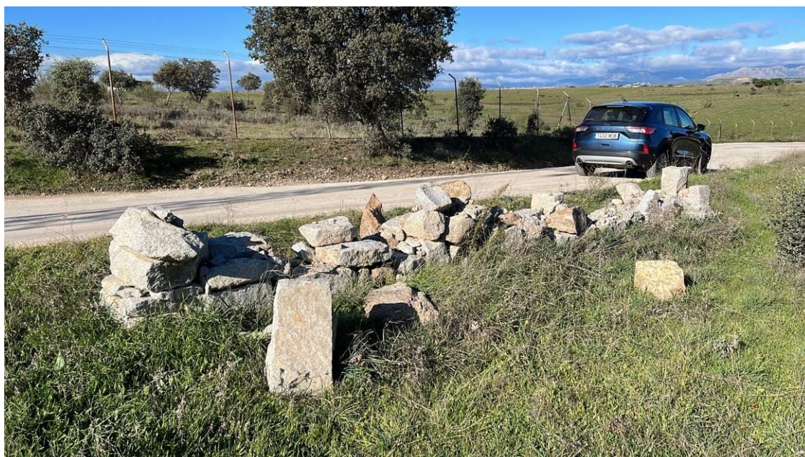
Figura 8. Tapia en la Vereda de las Tapias de Viñuelas y El Pardo desmantelada casi en su totalidad como consecuencia del vandalismo.
