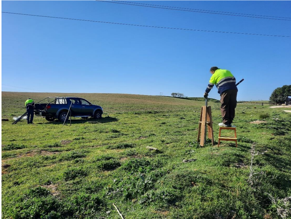
Figura 3. Instalación manual de postes para vallado de exclusión de ganado en la Vereda de Valdelagua o del Camino Ancho, en San Agustín de Guadalix (tramo embastecido LI122).
