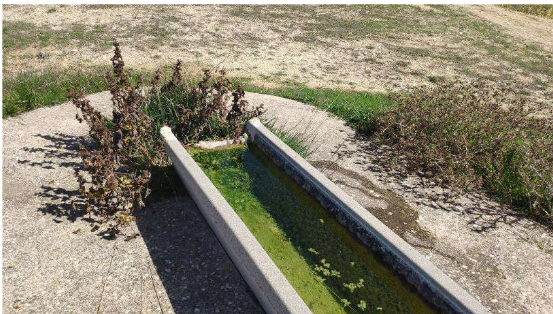
Foto 17. Extremo final del abrevadero a reparar (Fresneda de Altarejos) coincidente con el extremo donde ha de salir el agua del rebosadero para alimentar a los nuevos abrevaderos, los cuales se situarán a una cota inferior.
