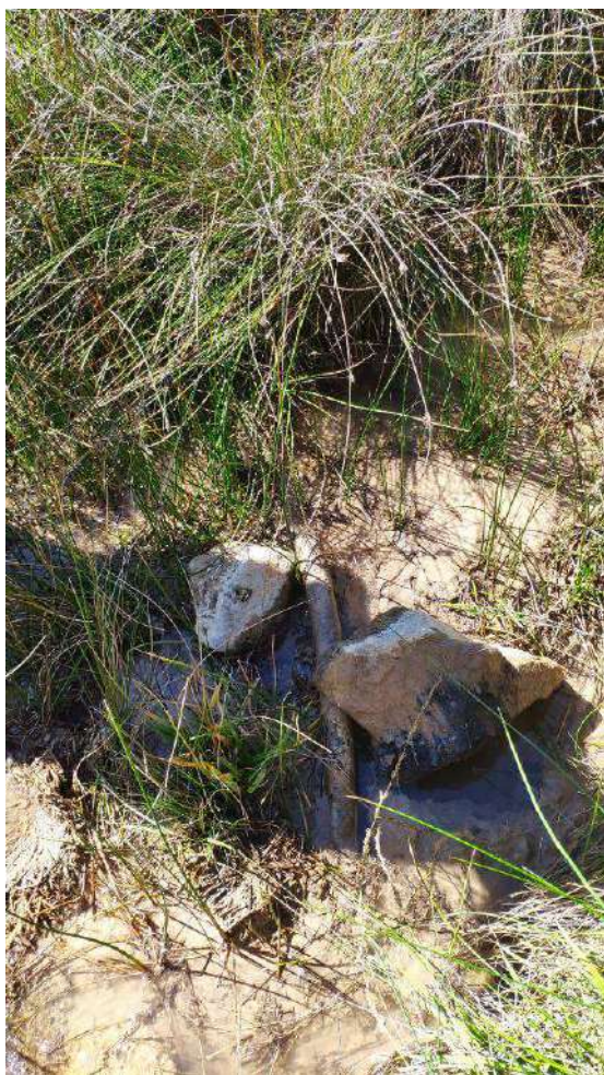
Foto 18. Estado de la captación actual.
